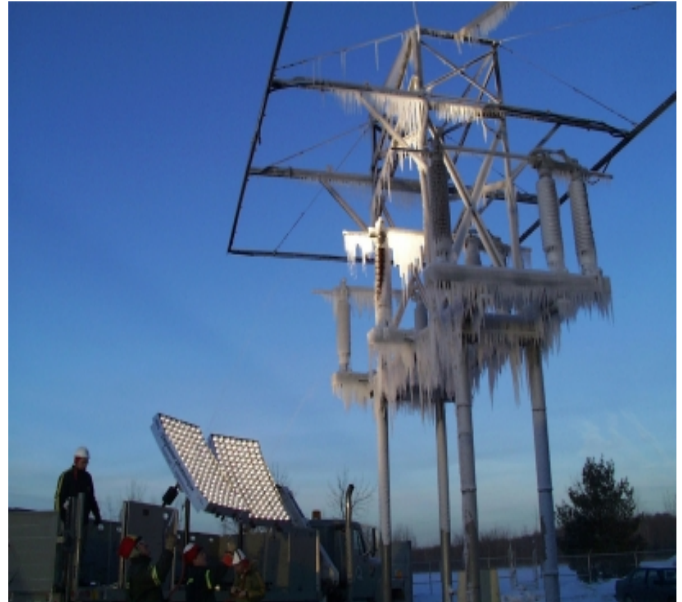
Essai de déglaceage au poste Duvernay - Sectionneur 120kV
